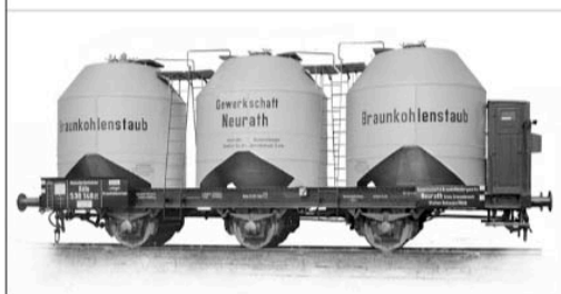
Den in Oekoven/Rhld. behelmten Köln 538 148 [P] lieferte Westwaggon Köln-Deutz am 16.8.28 nach derselben Zeichnung wie den oben abgebildeten Wagen der Michel-Werke an die Gewerkschaft des Braunkohlenbergwerks Neurath Kreis Grevenbroich. Werkfoto VWW, Stiftung RWWA 107-GN1315
